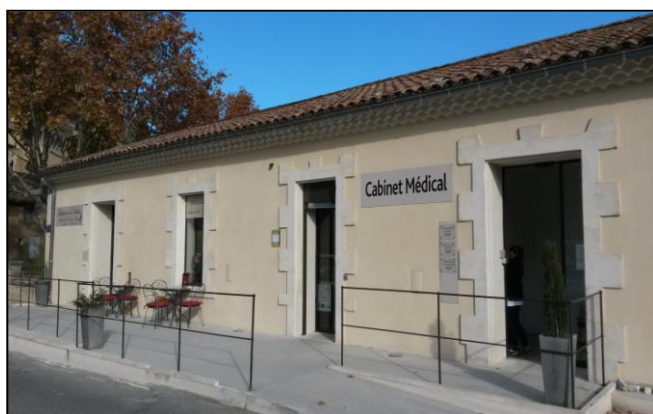
Cabinet médical, poste
