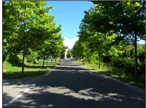
Entrée de village RD37
